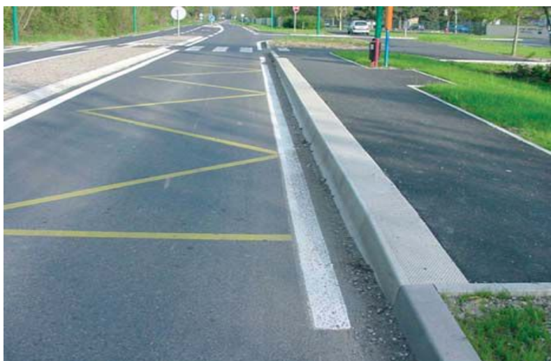
Photo d'un arrêt rendu accessible en milieu interurbain dans le Bas-Rhin avec présence d'une bande contrastée pour signaler la hauteur de marche (photo : J.-L. Stadler – CG67)
