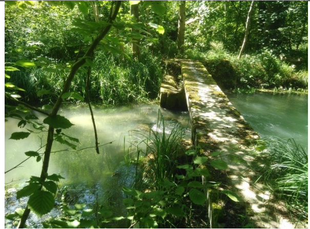
Passerelle avec culées plus étroites que le lit
