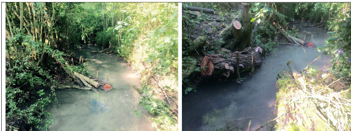
Epis déflecteurs réalisés en 2016 sur la Py
