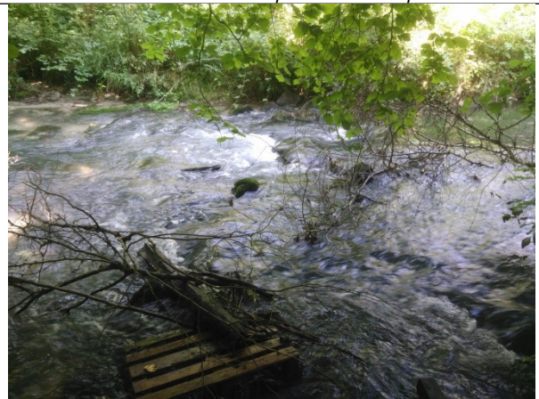
Radier en aval du pont SNCF
