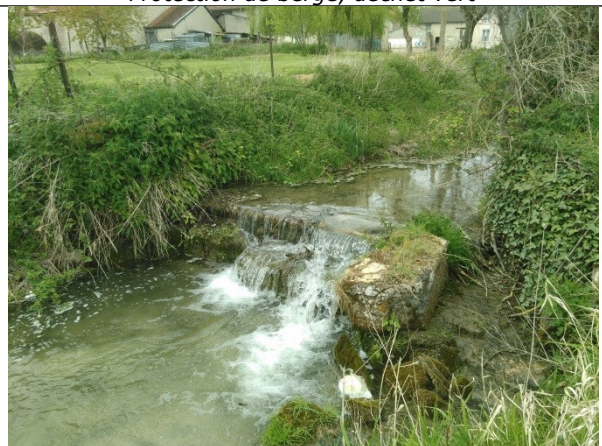
Seuil de fond à SAINTE-MARIE-A-PY, infranchissable
