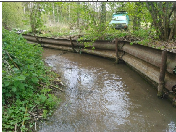
Protection de berge à SAINTE-MARIE-A-PY
