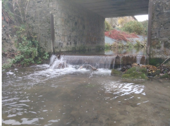
Radier de l'ancien moulin de la Ferme de l'Etang
