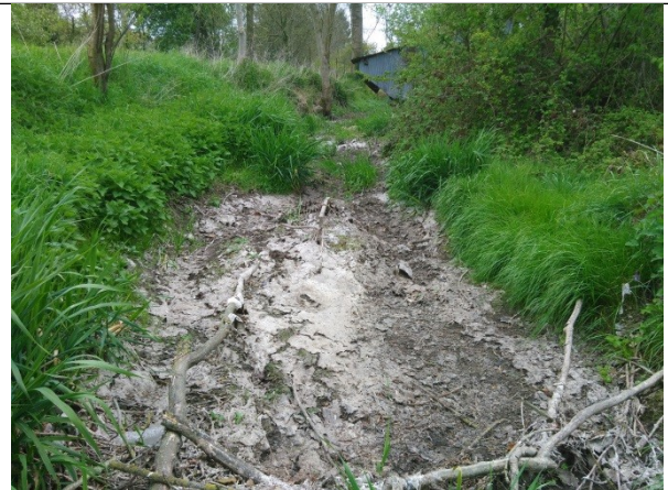
Colmatage du lit mineur de la Py par des déchets de cellulose et matière organique à la sortie d'un DO
