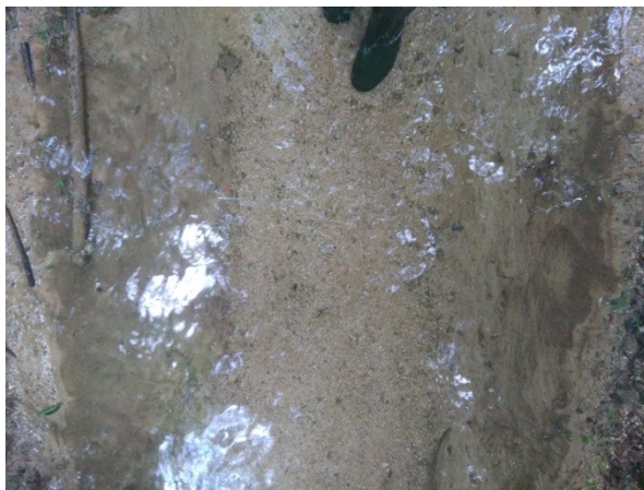
Colmatage du lit par les sables en rive droite et gauche.
