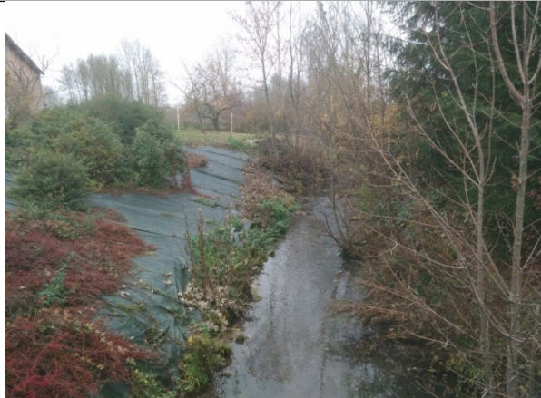
Ecoulement banalisé et ripisylve non appropriée à l'amont du pont de l'ancien moulin de la Ferme de l'Etang
