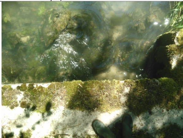
Radier en amont de la passerelle
