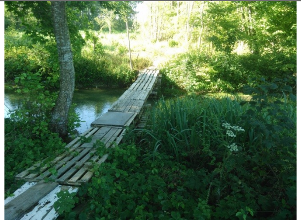
Passerelle rudimentaire disposée sur le cours d'eau
