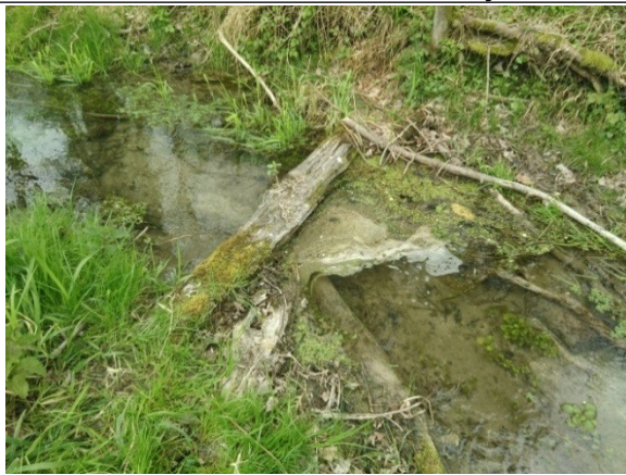
Seuil rudimentaire constitué de poutres, limitant
