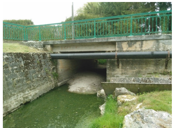
Colmatage du lit mineur de la Py par des déchets de cellulose et matière organique à la sortie d'un DO
