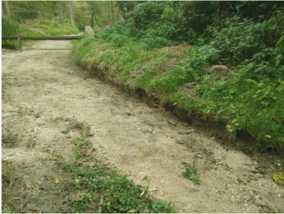
Aménagement du fond du lit (terrassement, reprise des berges...)
