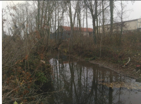
Ecoulements banalisés, fond du lit colmaté, aspect rectiligne du cours d'eau
