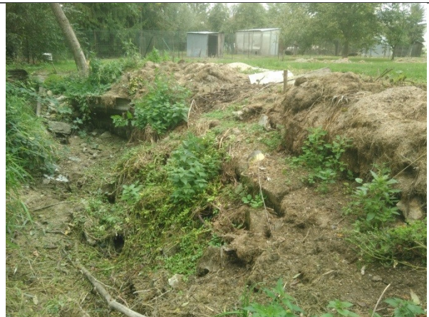
Protection de berge, déchet vert
