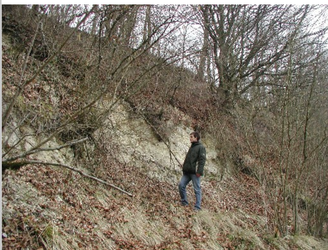
Illustration 7: Escarpement résiduel au sommet du glissement
