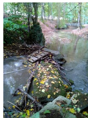
Blocs du moulin de Fontenelle
