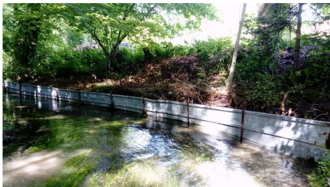
Exemple de protection rudimentaire
